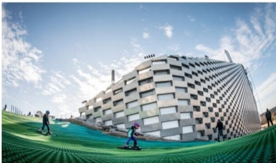
Рисунок 31. Инновационный завод по переработке мусора в Копенгагене Amager Bakke
